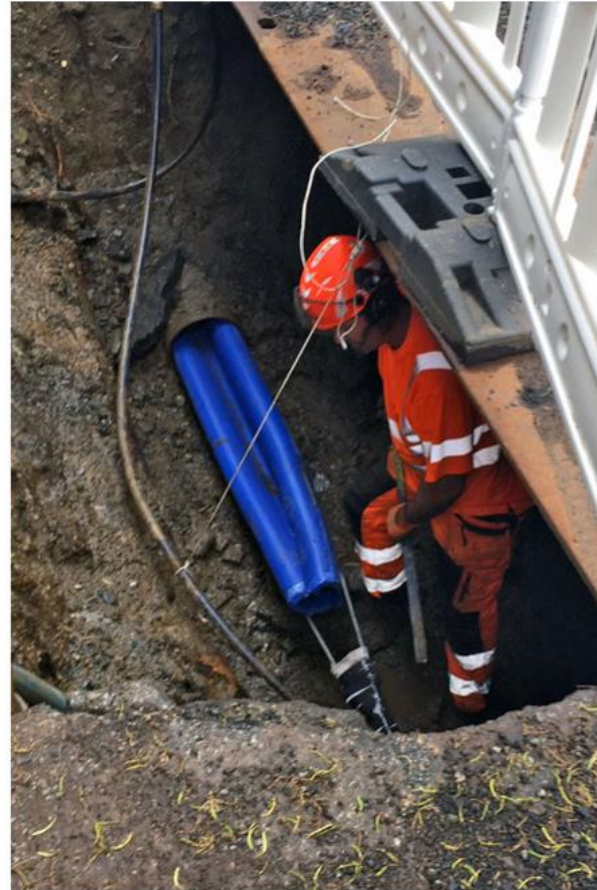
Compact Pipe-røret kommer oppkveilet på trommel og er foldet i en C-form når det blir trukket gjennom det gamle røret. Røret folder seg ut og tetter inni eksisterende rør når det blir tilsatt trykk og varme. På jobb for Olimb Rørfornyng AS: Geir Johansen, Christoffer Krabbsjö, Robert Andersson, Andreas Andersson.
