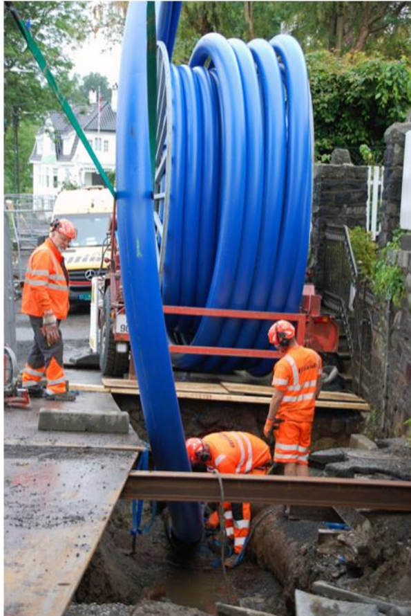
Compact Pipe-røret kommer oppkveilet på trommel og er foldet i en C-form når det blir trukket gjennom det gamle røret. Røret folder seg ut og tetter inni eksisterende rør når det blir tilsatt trykk og varme. På jobb for Olimb Rørfornyng AS: Geir Johansen, Christoffer Krabbsjö, Robert Andersson, Andreas Andersson.
