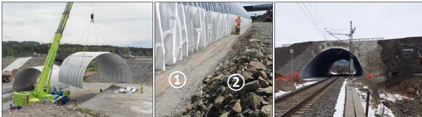
Omfylling med knust stein. Tjernli bru, Norge (2019).
