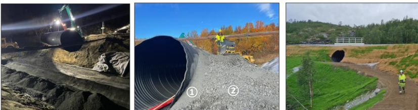
Omfylling med velgradert knust stein. Bolna jernbanekulvert, Norge (2022).
