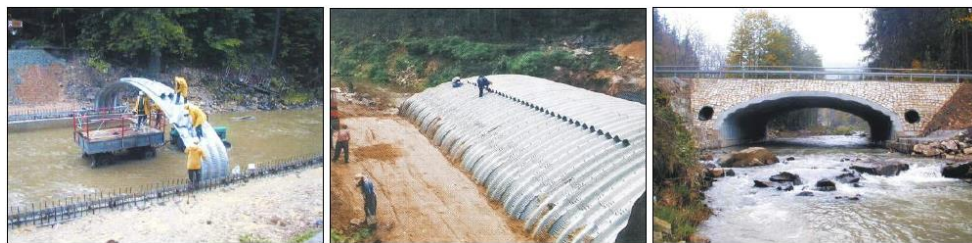
Omfylling med lokal (stedlige), naturlig avsatt sand og grus. Bystrzyca Dusznicza, Polen (2001).
