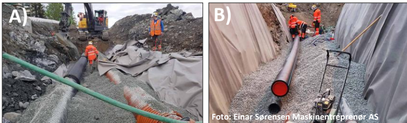
To eksempler med omfylling i VA-grøfter med 8/16mm (ensgradert puk) i Norge.
