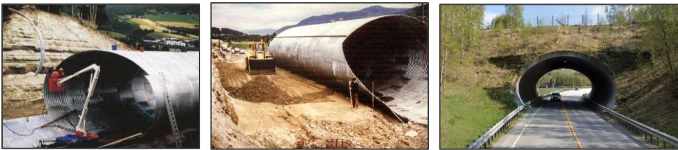
Omfylling med lokal (stedlig) naturlig avsatt sand og grus. Dovre, Norge (1985).
